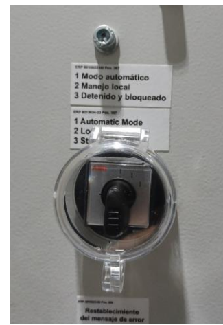
Selector de comunicaciones con el soporte instalado y en posición 1 (condiciones de operación). Communications selector with the support installed and in position 1 (operating conditions).
