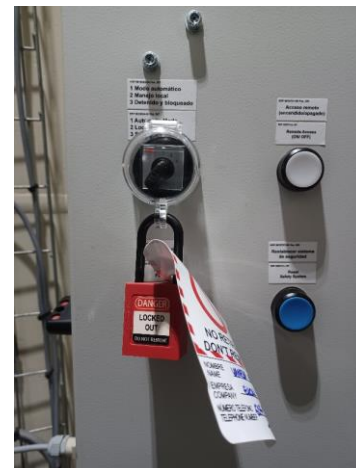
Selector de comunicaciones con el soporte instalado y en posición 1 (condiciones de operación). Communications selector with the support installed and in position 1 (operating conditions).
