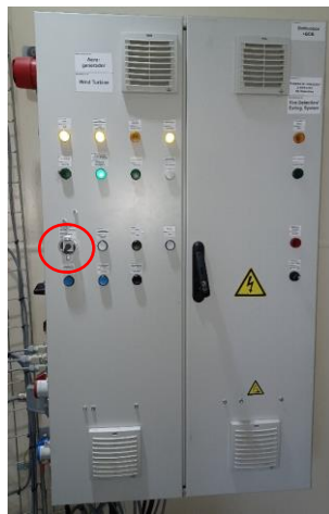
Frontal del armario Bottombox. Sobre la imagen se destaca el selector de las comunicaciones Bottombox cabinet front. The communications selector stands out on the image.
